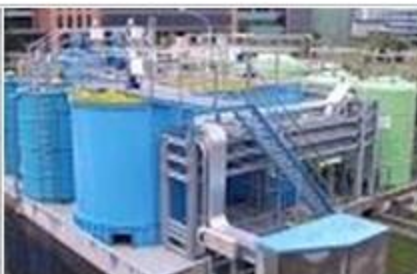
廢水系統新建工程
