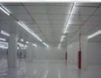
無塵室系統工程
